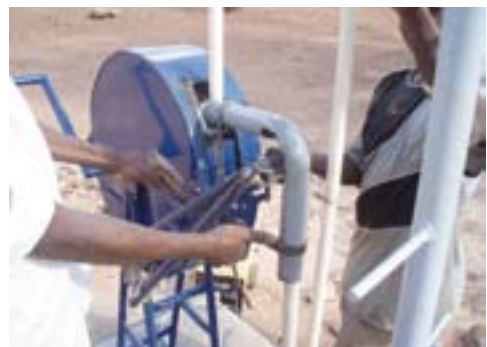
FIGURA 42. PROTECÇÃO DA CORDA COM TUBO DE PVC
