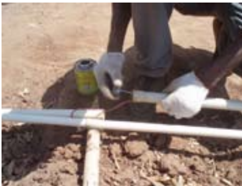
FIGURA 32. INTRODUÇÃO DA CORDA E UNIÃO DOS TUBOS COM COLA
