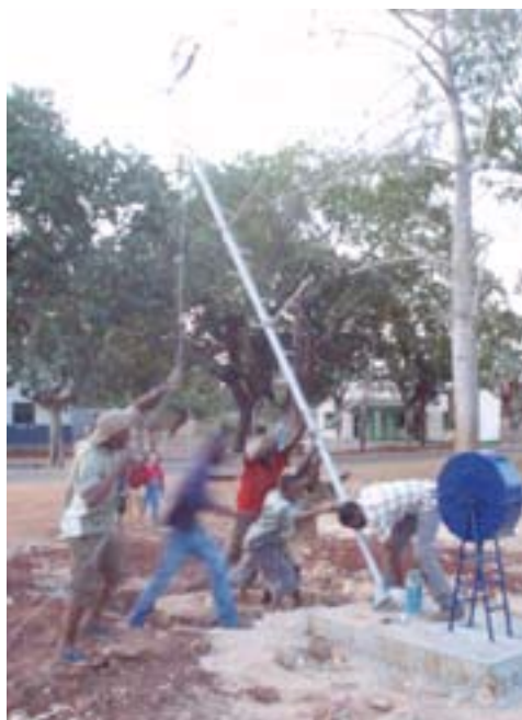
FIGURA 27. COLOCAÇÃO DO MASTRO
