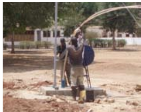
FIGURA 37. INTRODUÇÃO DOS TUBOS NO POÇO
