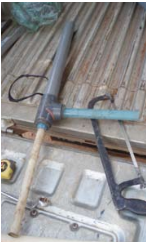
FIGURA 38. ACABAMENTO TROÇO DE IMPULSÃO
