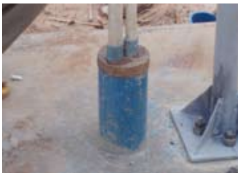
FIGURA 41. COLOCAÇÃO DA TAMPA COM TUBOS E CORDA DE LEVANTAMENTO
