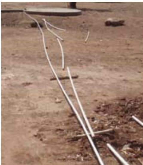
FIGURA 28. PREPARAÇÃO DOS TUBOS
