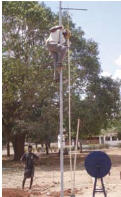
FIGURA 39. COLOCAÇÃO E SUPORTE DAS TUBAGENS
