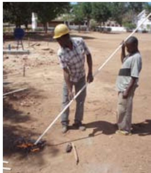
FIGURA 29. PREPARAÇÃO DE JUNÇÕES POR AQUECIMENTO
