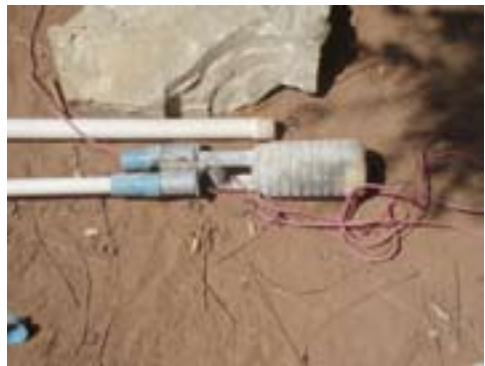
FIGURA 33. COLOCAÇÃO DA GUIA INFERIOR
