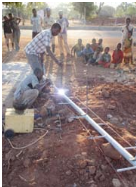
FIGURA 26. PREPARAÇÃO DO MASTRO
