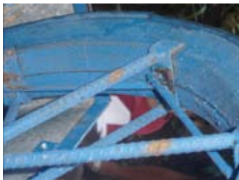
FIGURA 56. ALGUNS ELEMENTOS METÁLICOS QUE PRECISAM DE SER PINTADOS
