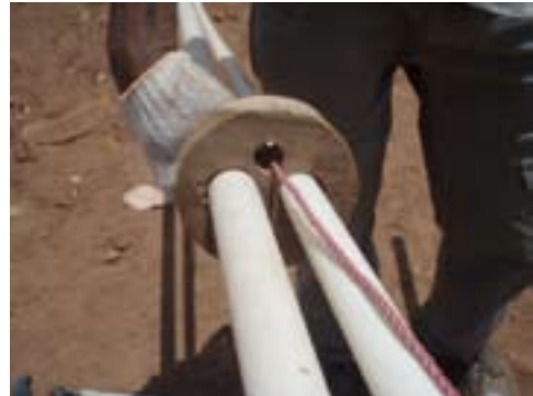
FIGURA 35. COLOCAÇÃO DA TAMPA COM TUBOS E CORDA
