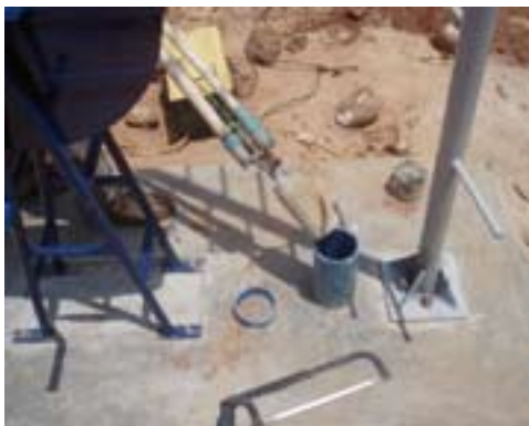
FIGURA 36. INÍCIO DE INTRODUÇÃO DA GUIA INFERIOR E DOS TUBOS NO POÇO
